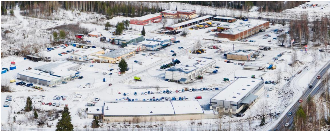
Kaapelikadun yritysalueita lounaasta. Oikealla Otavankatu ja takana valtatie 13.
